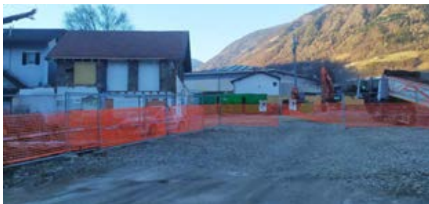
Die Baustelle am Bauhof Meran
